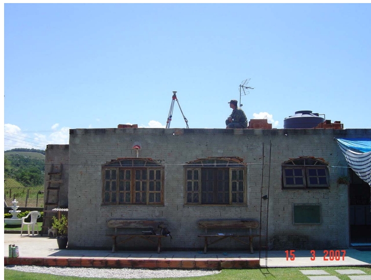
FIGURA B.2 - Levantamento em topo de edificação.
