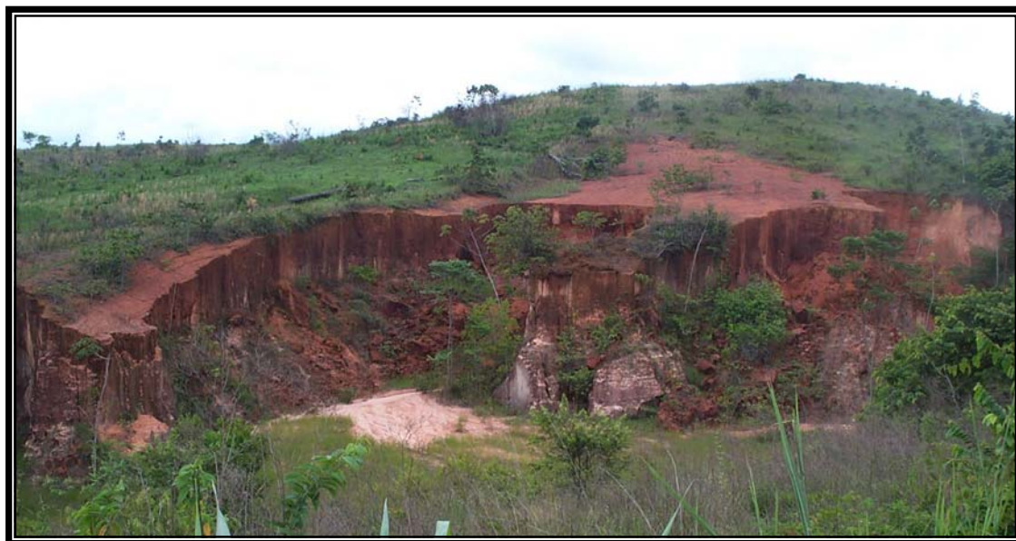
FIGURA 5.26 – Área de pastagem com voçoroca.
