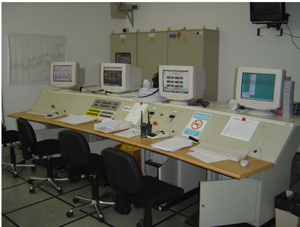
FIGURA 3.8 - Sala de controle.
