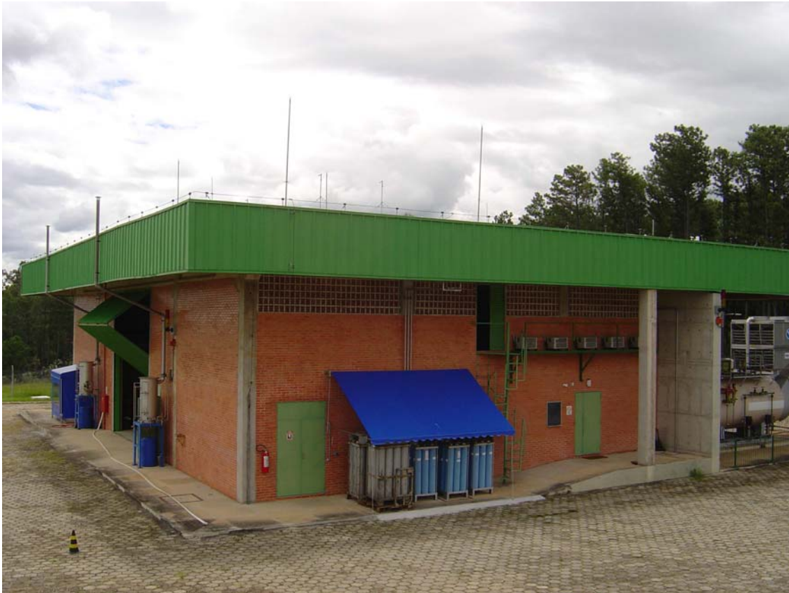
FIGURA 3.1 - Vista geral do BTSA.
