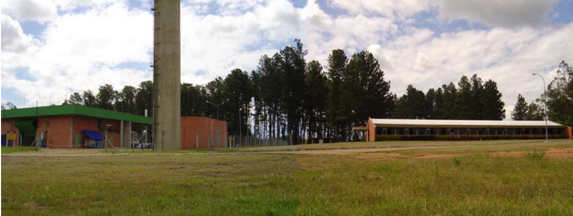
FIGURA 3.2 - Vista geral do BTSA.
