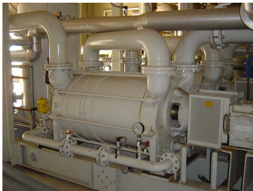
FIGURA 3.5 - Bombas de anel líquido.
