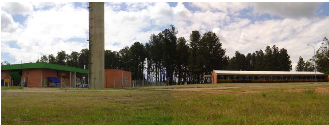
FIGURA 3.1 - Vista geral do BTSA.
