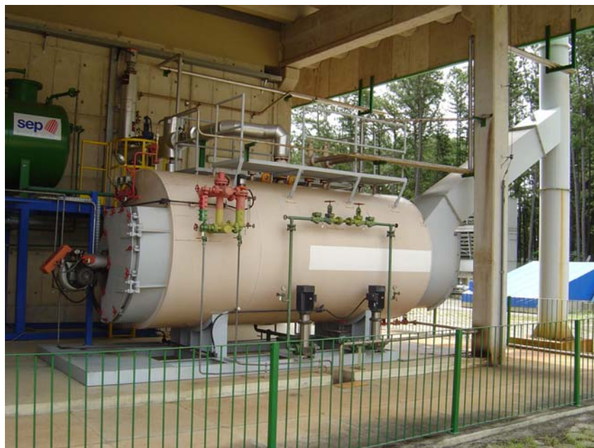
FIGURA 3.4 - Caldeira e super aquecedor.
