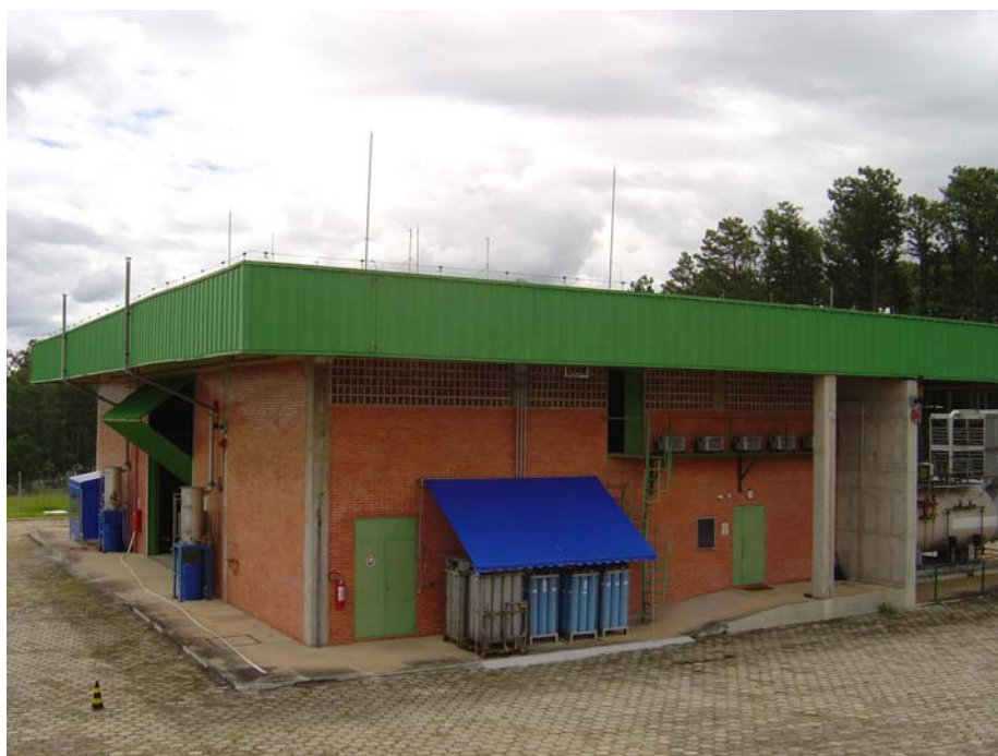
FIGURA 3.2 - Vista geral do BTSA.
