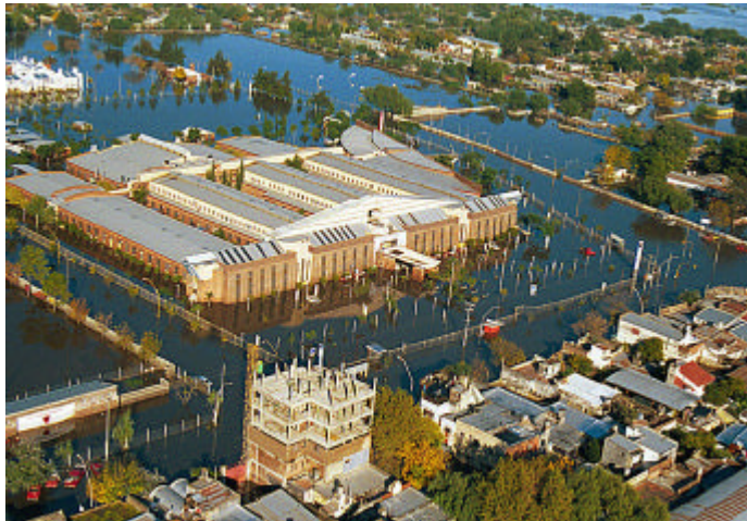
Figura 43 Fotografía del Hospital de Niños de la ciudad de Santa Fe durante la crecida de 2003 del río Salado
