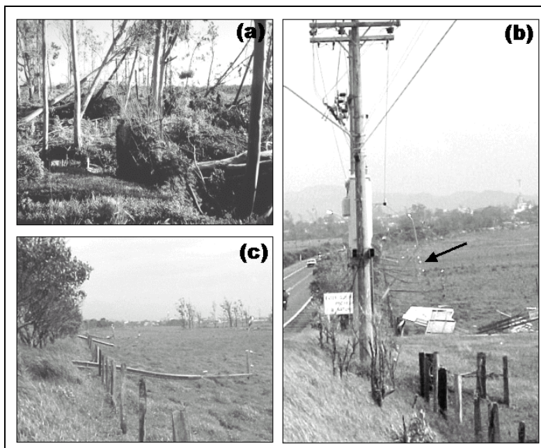
Figura 9 – Quedas de árvores (a) e de linhas de transmissão de energia (b e c).
