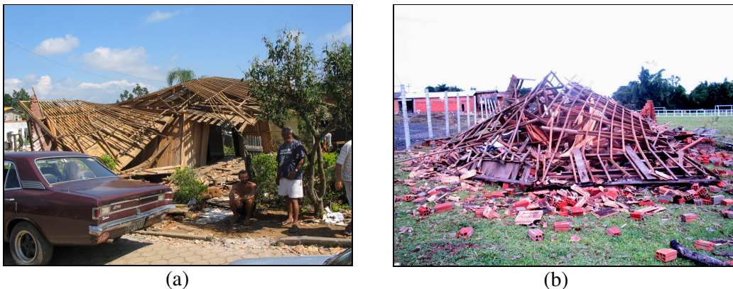
Figura 13 – Danos ocasionados pelo tornado F2 ocorrido no município de Criciúma em janeiro de 2005: (a) casa de madeira com o telhado seriamente destruído; (b) casa de tijolos totalmente destruída.
