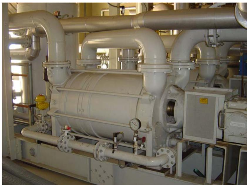
FIGURA 3.5 - Bombas de anel líquido.
