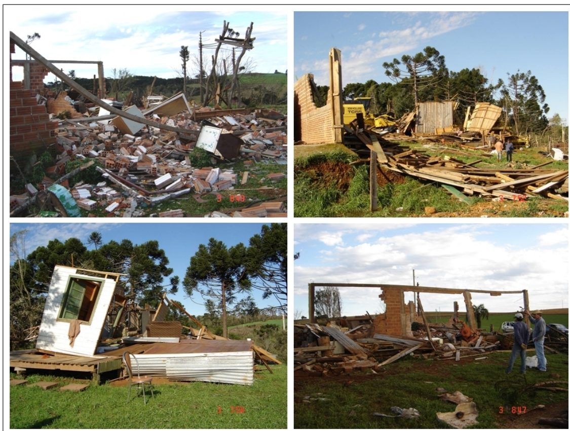
Figura 13 – Danos em edificações na área rural do município.
