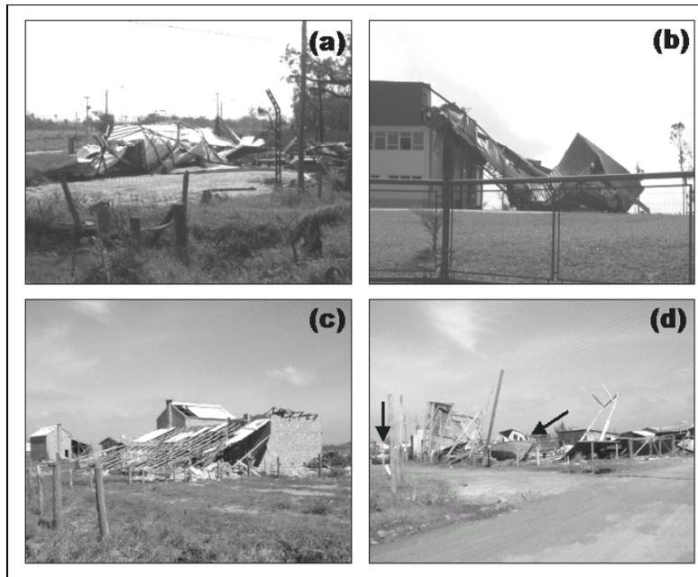
Figura 7 – Tipos de danos causados em galpões pela ação dos ventos: (a e b) destruição total e parcial de galpões metálicos; (c) destruição parcial de estufa de fumo; e (d) destruição total de um estaleiro.
